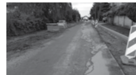
Inne inwestycje też dobiegają końca: na ul. Krynickiej odtwarzana jest nawierzchnia wg projektu wykonanego ze środków rady osiedla, zakończono prace na ul. Kaczmarka etap I, nową nawierzchnię zyskała ul. Lubieńska, a za chwilę wyremontowany zostanie chodnik przy SAMie, prowadzący do szkoły.
